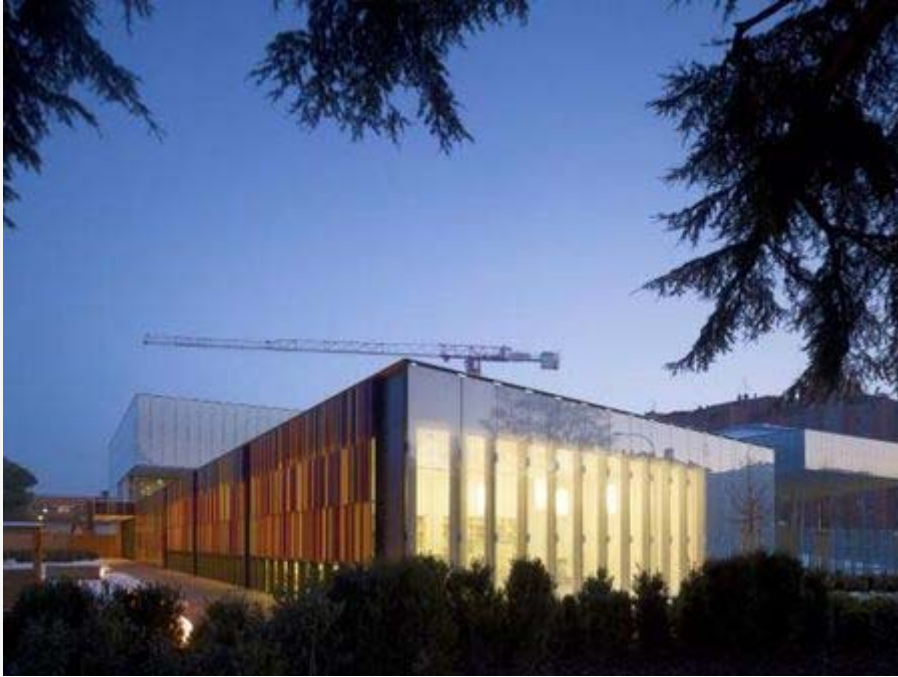
Fondazione Mast | La nuova sede
