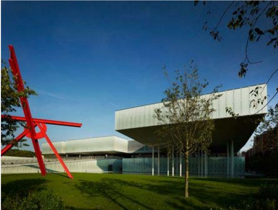
Fondazione Mast | La nuova sede
