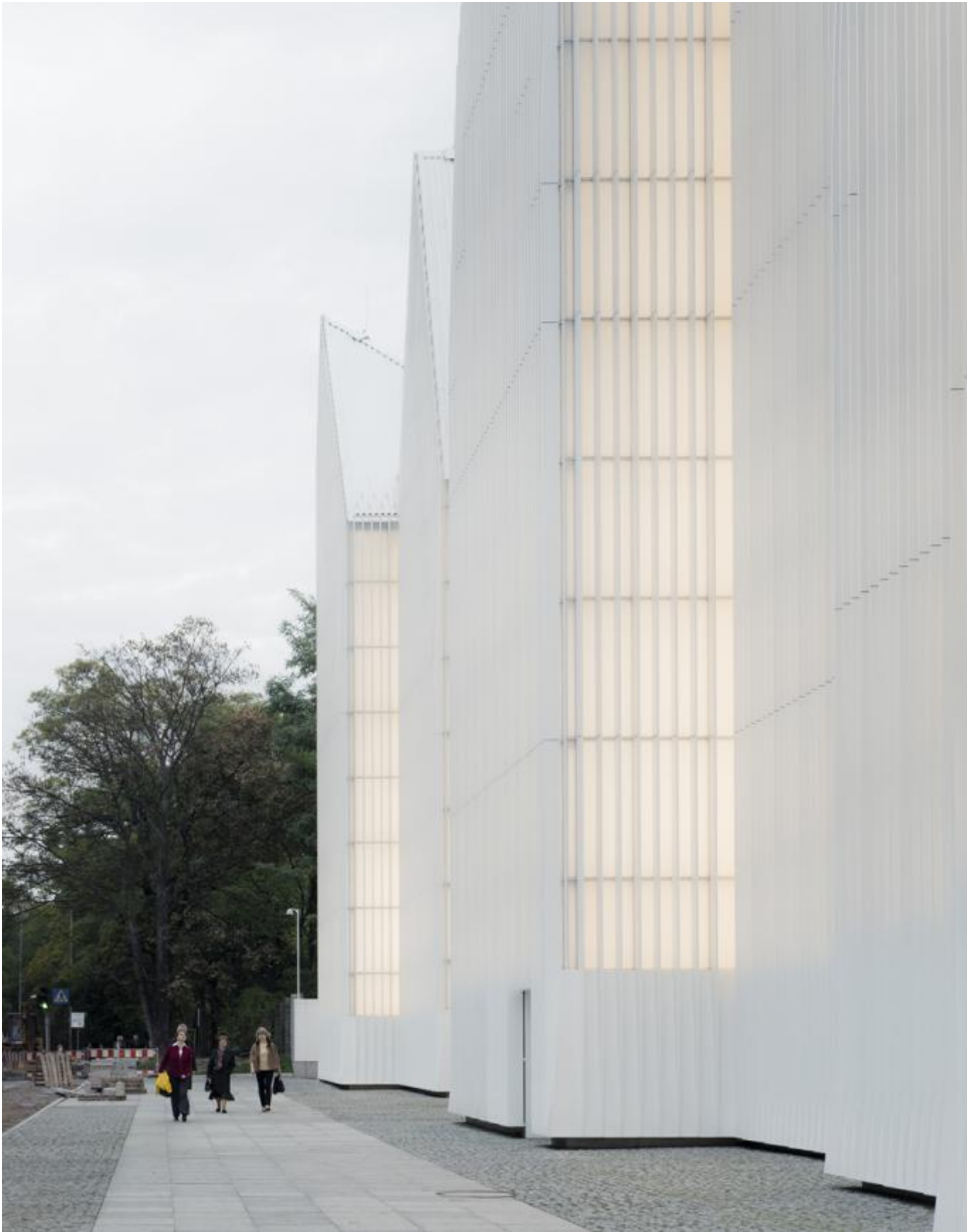
Detalle de fachada. Auditorio de la Filarmónica de Szczecin por Barozzi / Veiga. Fotografía © Simon Menges. Señala encima de la imagen para verla más grande.
