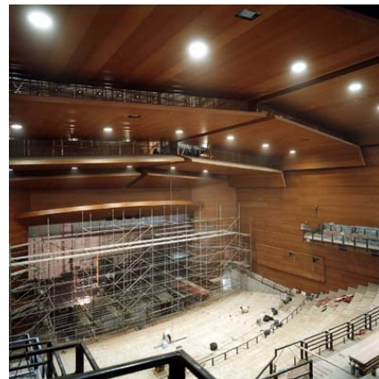
Un momento de la construcción.
