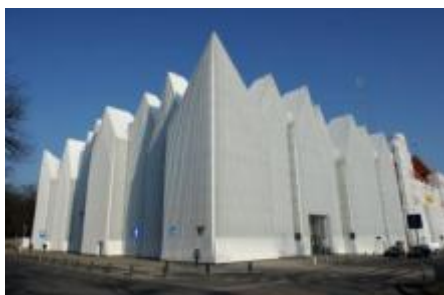
Budynek Filharmonii Szczecińskiej. Fot. PAP/M. Bielecki
