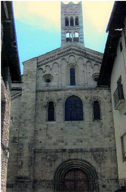
Fachada principal y campanario.
