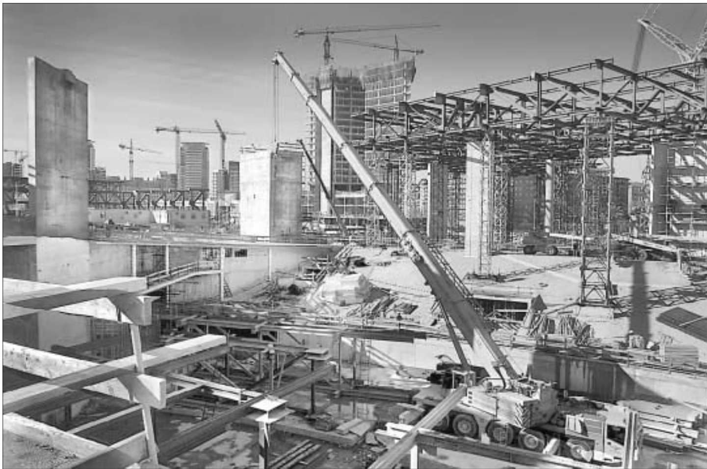
La caja que acogerá el auditorio del edificio Fórum se perfila ya bajo la compleja estructura del edificio. / MARCELLÍ SÁENZ
