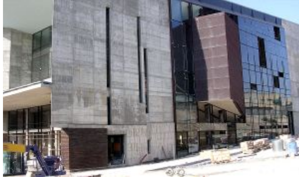
FACHADA LATERAL DEL TEATRO 'VILLA DE MOLINA' QUE SE INAUGURARÁ EN OCTUBRE. / PEPE JIMÉNEZ.
