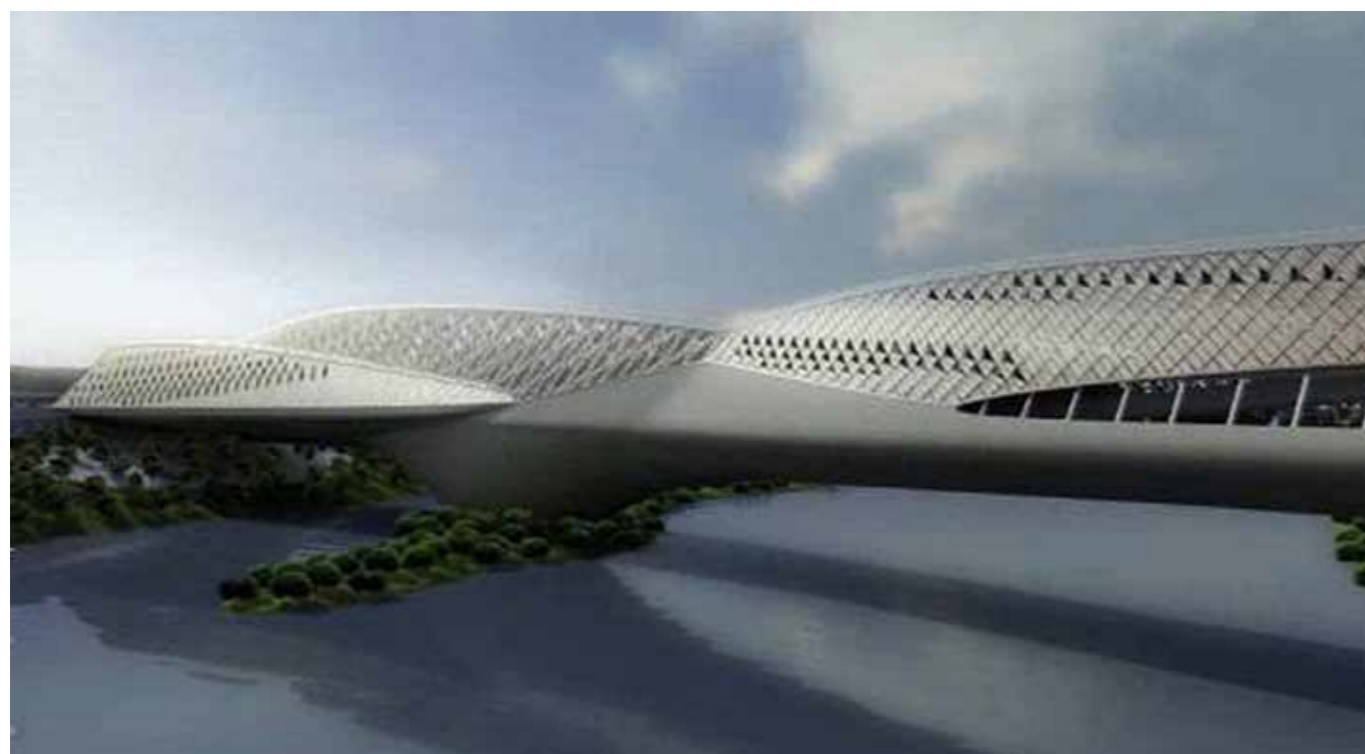
Pabellón Puente (Zaragoza) Arquitecto: Zaha Hadid. Imagen: Placo
