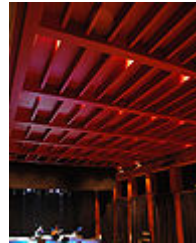
Revestimiento en madera de Okume
