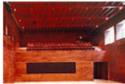
Revestimiento en madera de Okume
