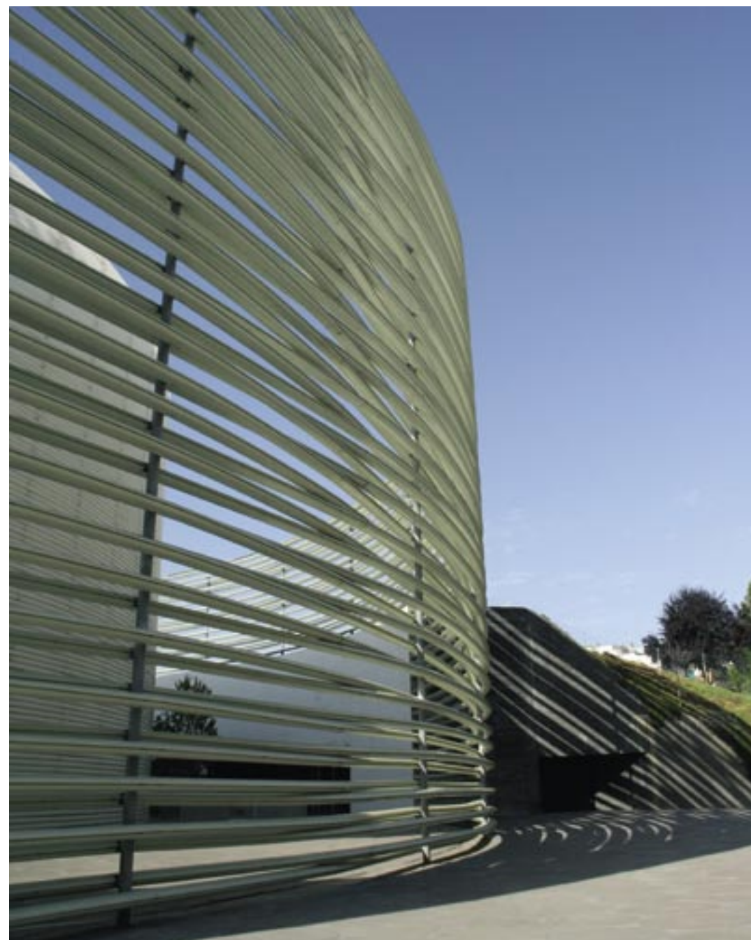
De izquierda a derecha: Tubos de plexiglás del anillo interior; Tubos de fibra de vidrio y poliéster del anillo exterior; Zona de asientos bajo la silueta del graderío del auditorio. Fotos: Promateriales
