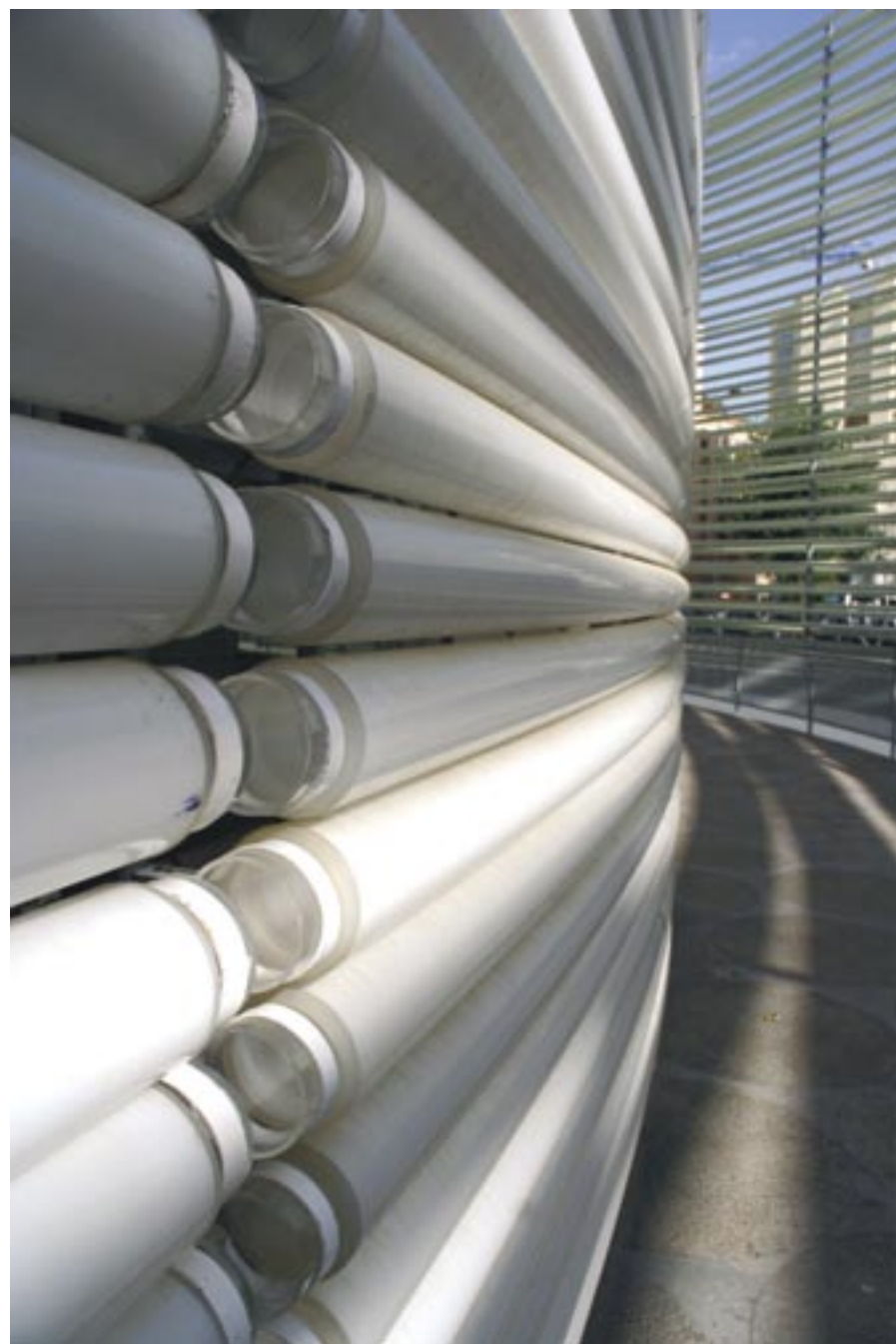
De izquierda a derecha: Tubos de plexiglás del anillo interior; Tubos de fibra de vidrio y poliéster del anillo exterior; Zona de asientos bajo la silueta del graderío del auditorio. Fotos: Promateriales
