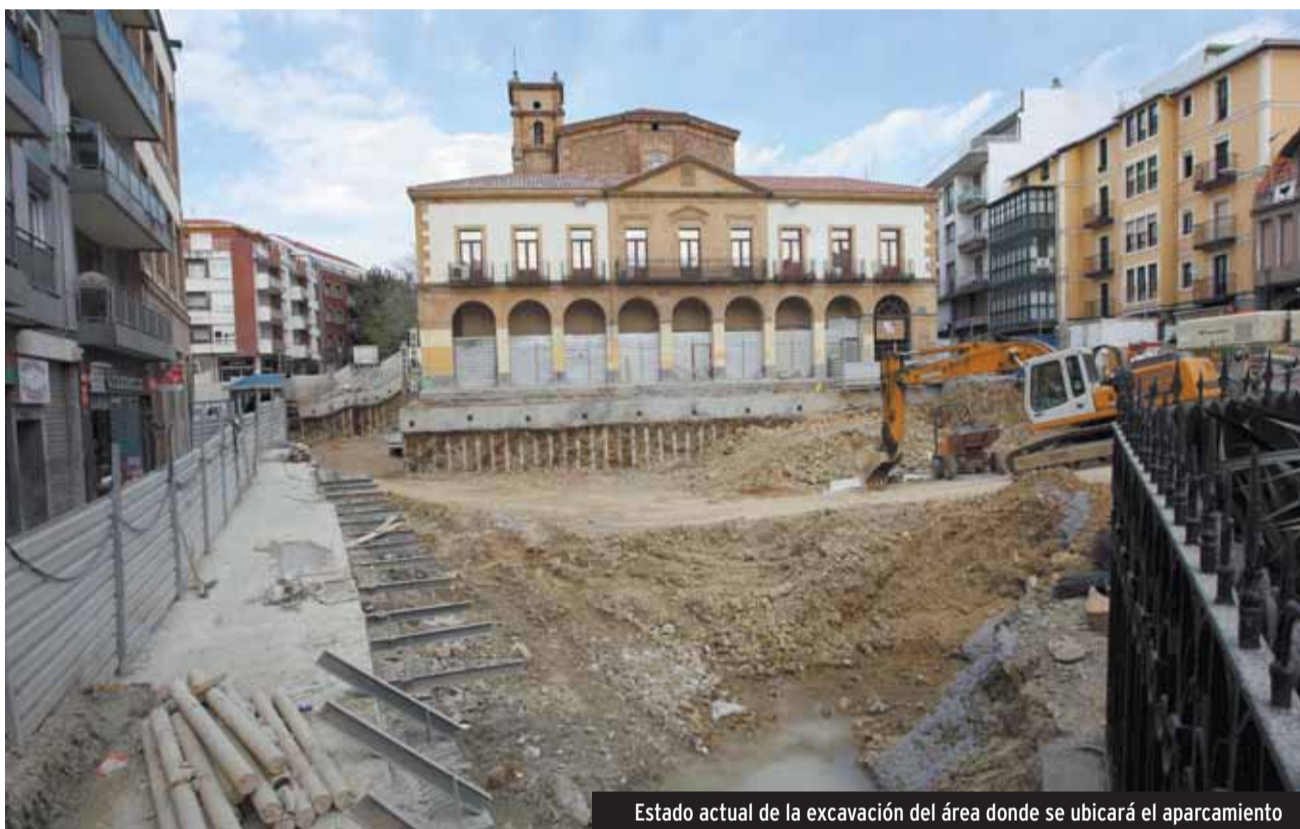
Estado actual de la excavación del área donde se ubicará el aparcamiento
