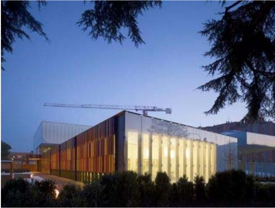
Fondazione Mast | La nuova sede
