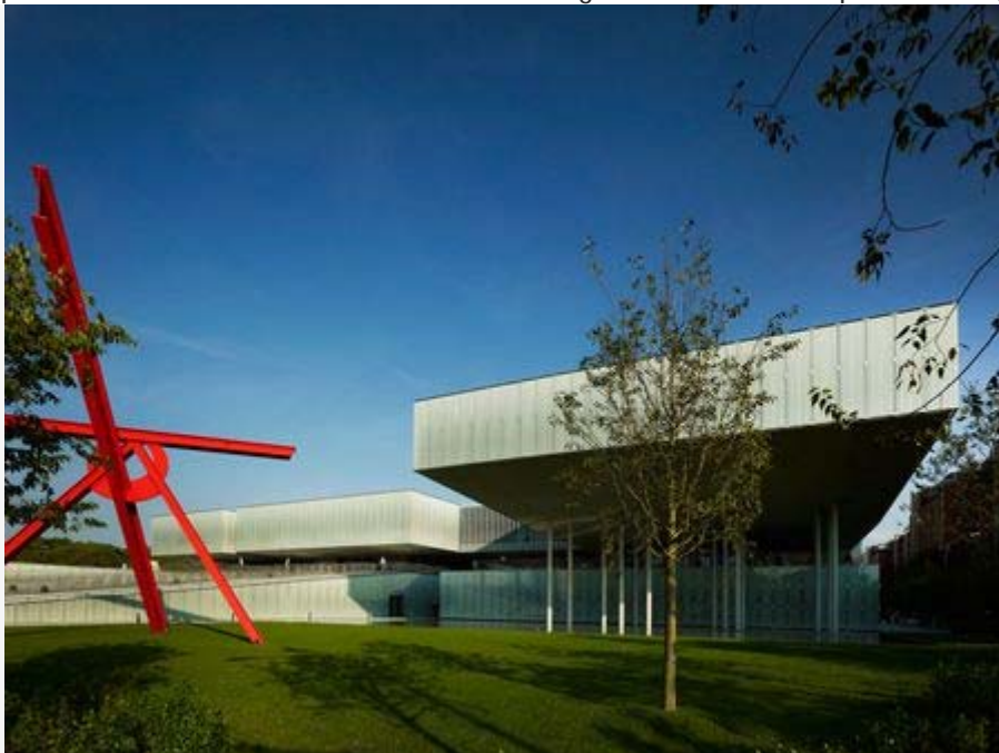
Fondazione Mast | La nuova sede
