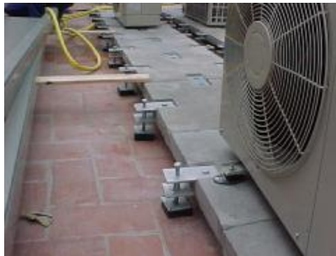
Foto Realizada por ALDOVIER: Losas flotantes modulares "LOSAS Q" patentadas por I. J. Jackson
