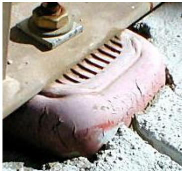
Fotos Realizadas por R. TORRES ; Patologías de amortiguadores de caucho-metal mal fabricados o diseñados.
