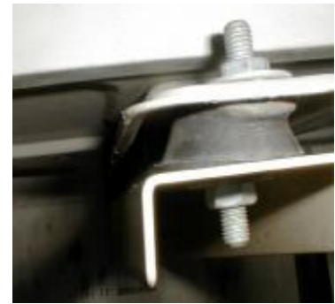
Fotos Realizadas por R. TORRES ; Patologías de amortiguadores de caucho-metal mal fabricados o diseñados.
