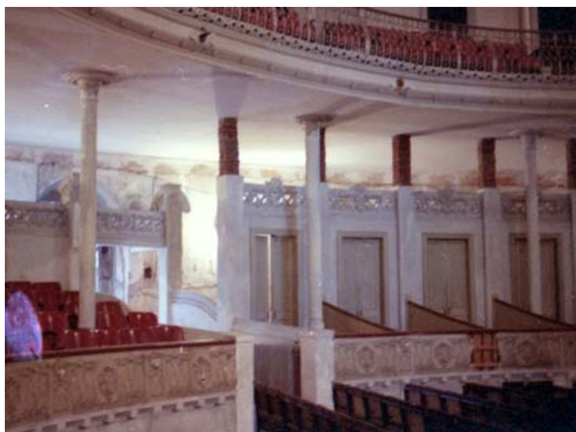
Figura 5. Inicio de la construcción de los tabiques de cierre entre la sala y las circulaciones (fotografía tomada en 1986).
