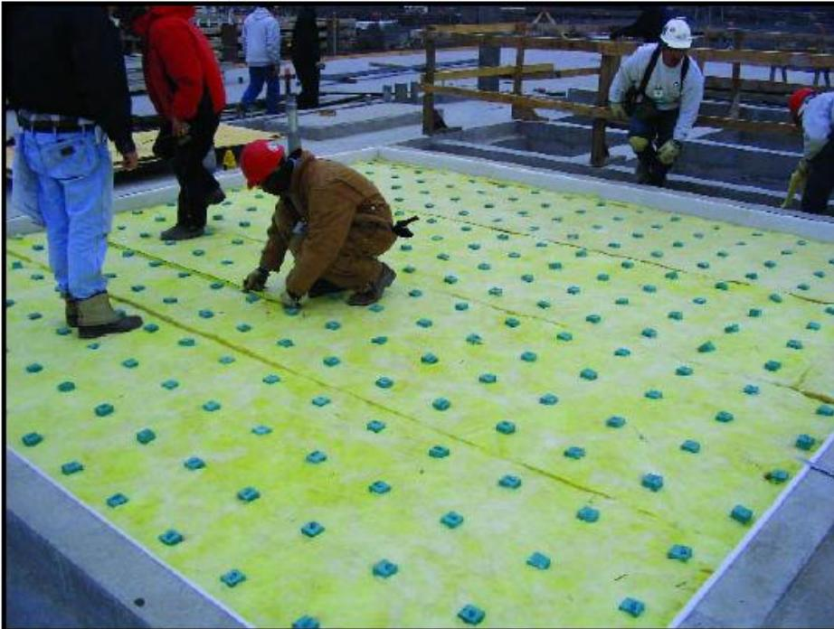
Slika 26: polaganje elastomeričnih izolatorjev in mehke kamene volne
