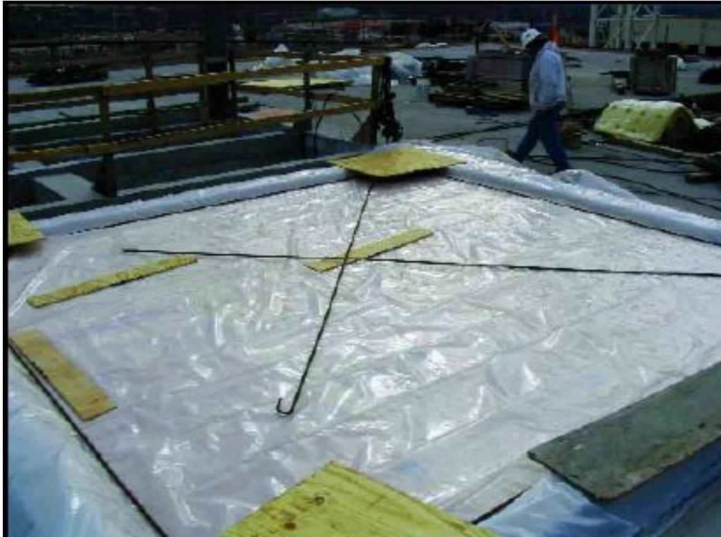
Slika 28: paropropustna folija, pripravljeno za vlivanje betonske plošče
